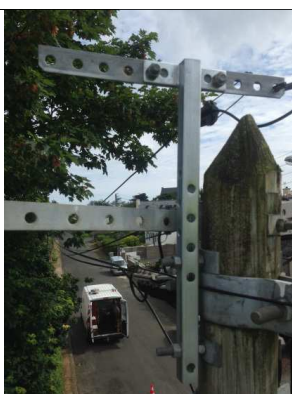
Exemple de rehausse refo 2 implantée latéralement avec deux boulons traversant de 14 x 225 mm et plaquettes demi-lune montées après perçage du poteau. Utilisation de plaque demi-lune + écrou pour passage de collier. Montage d'une traverse 5/14 avec 2 boulons de 14 x 25 mm.
