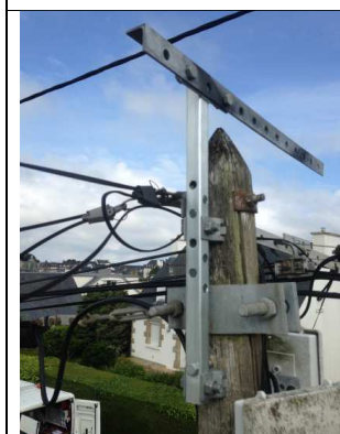
Exemple de rehausse refo 2 implantée latéralement avec deux boulons traversant de 14 x 225 mm et plaquettes demi-lune montées après perçage du poteau. Utilisation de brides pour passage du collier fixée avec 2 boulons 14 x 60 mm sur la rehausse. Montage d'une traverse 5/15 avec 2 boulons de 14 x 25 mm.
