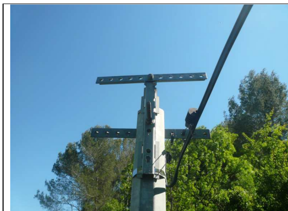
Exemple de rehausse refo (ancien modèle) implantée en face opposée à l'armement sur poteau métal avec 1 cerclage et sur boulon tête de poteau fixée avec un écrou. Montage d'une traverse 5/14 avec 1 boulon. 14 x 25 mm.
