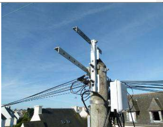
Exemple de rehausse refo (ancien modèle) implantée latéralement sur poteau bois avec 2 boulons traversant de 14 x 225 mm et plaquettes demi-lune montées après perçage du poteau. Montage d'une traverse 5/14 avec entretoise de 30 mm et boulon de 14 x 60 mm.
