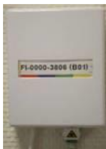
Figure 8 : FTTE passif NRO - exemple de PTO
